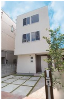
シンプルなデザインの3階建ての建物外観。メールボックスもモダン
