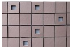
浮き上がったように見えるタイルもデザインの一部
